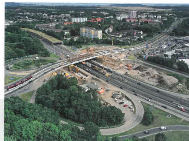
Zustand mit Behelfsbrücken unter Verkehr
