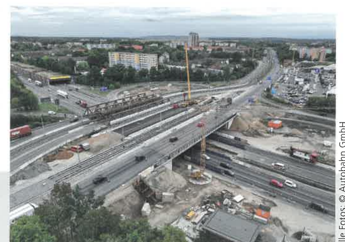
Zustand nach Fertigstellung der Brückenüberbauten und bereits umgelegter Fahrtrichtung Süd
