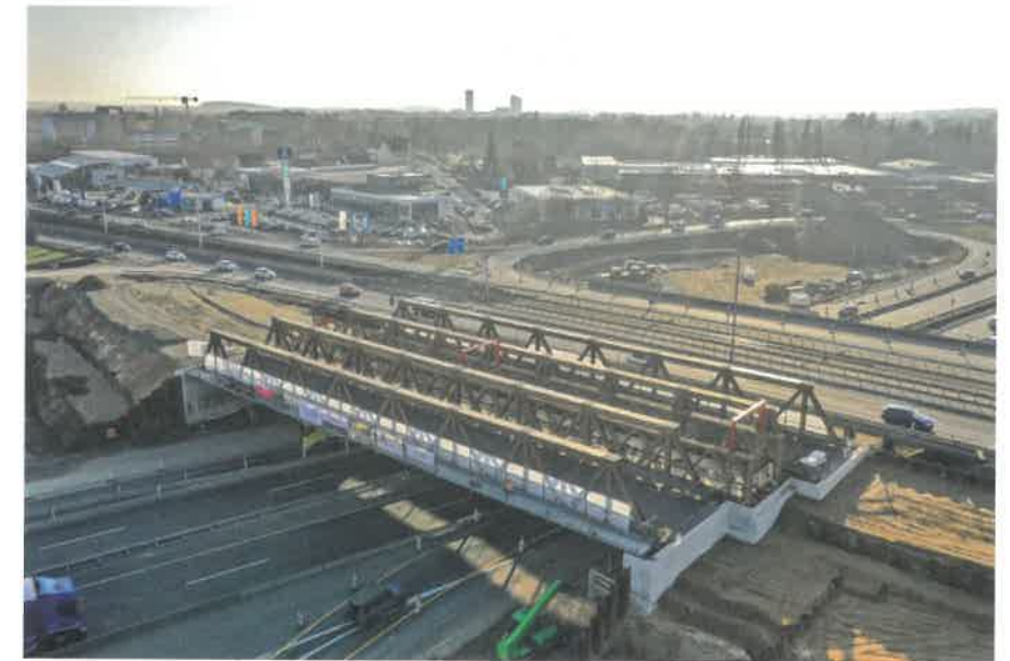
Zustand nach Einbau der Behelfsbrücken
