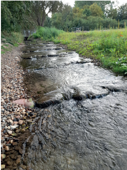
Abb.2 Ersatz des Sohlabsturzes der Wabe in Obersickte durch die neue Sohgleite
