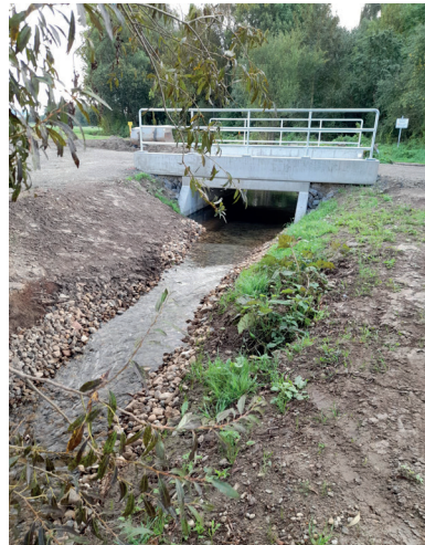
Abb.1 Renaturierter Wehr-Abschnitt in Neuerkerode
